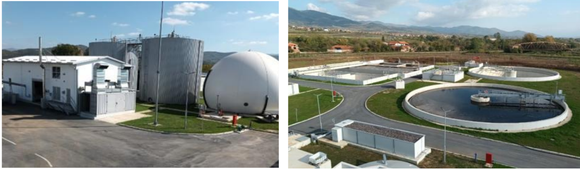
Слика бр. 4: Постројење за пречишћавање отпадних вода Врања
