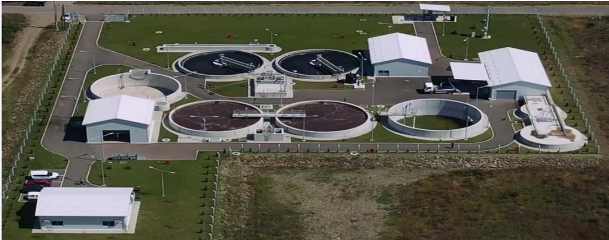
Слика бр. 3: Постројење за пречишћавање отпадних вода Рашке, Рвати
