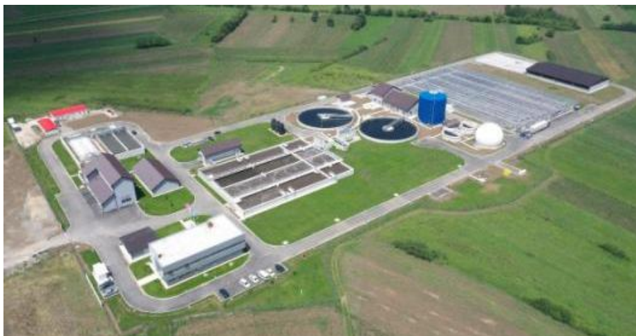
Слика бр. 6: Постројење за пречишћавање отпадних вода града Крушевца
